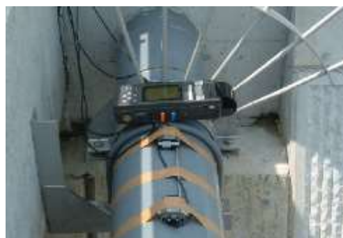
流量調査状況(超音波流量計)
