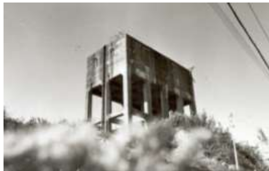
〔創設時の配水池〕
