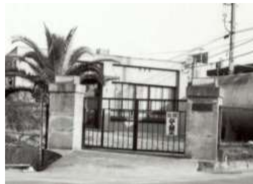
〔羽曳山配水場〕
