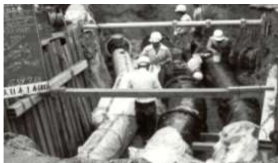
〔配水管布設工事 φ 400・φ 600・φ 500〕
