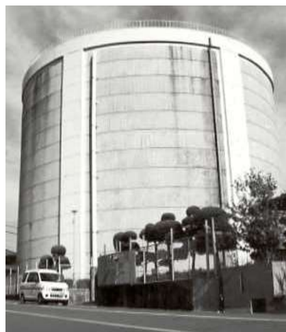
〔高圧配水池〕(平成21年解体撤去)
