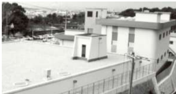
〔羽曳山配水場〕
