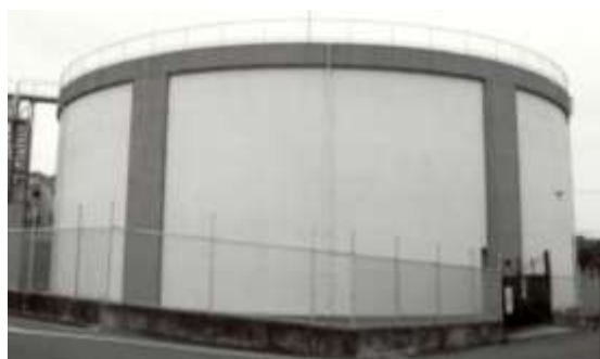
〔低区第2配水池〕
