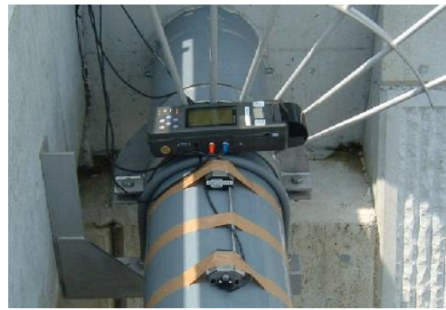
流量調査状況(超音波流量計)
