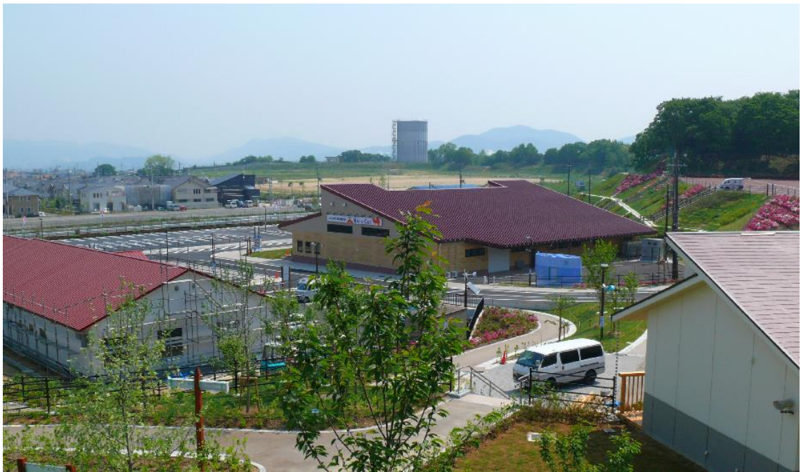
道の駅 しらとりの郷・羽曳野 （高区配水池）
