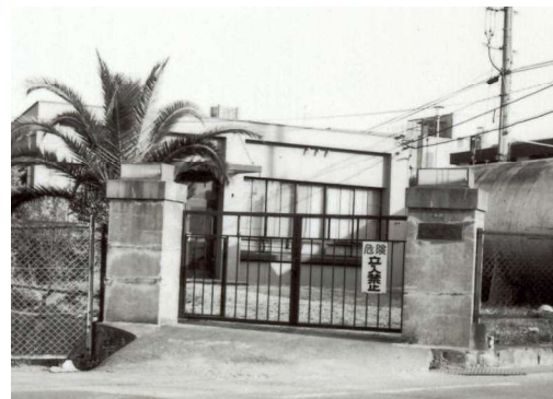
〔羽曳山配水場〕
