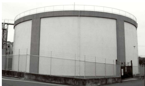
〔低区第2配水池〕
