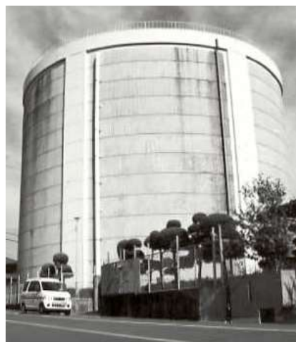
〔高圧配水池〕(平成21年解体撤去)
