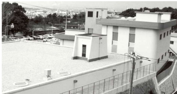
〔羽曳山配水場〕
