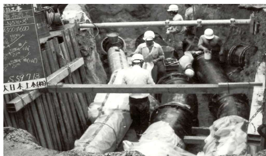
〔配水管布設工事 φ400・φ600・φ500〕
