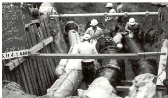
〔配水管布設工事 φ400・φ600・φ500〕
