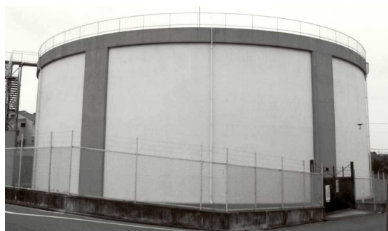
〔低区第2配水池〕
