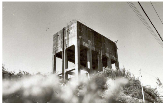
〔創設時の配水池〕
