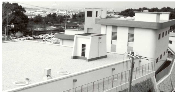
〔羽曳山配水場〕
