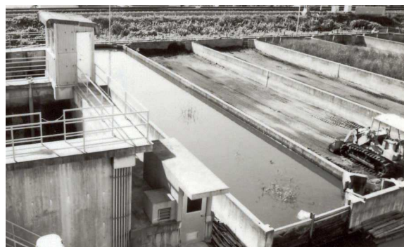
〔石川浄水場汚泥処理設備〕
