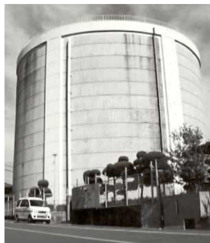
〔高圧配水池〕(平成21年解体撤去)
