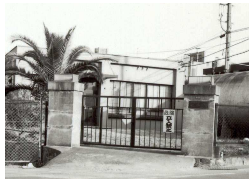
〔羽曳山配水場〕
